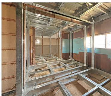
複数台設置／広範囲を守るシェルター施工事例
